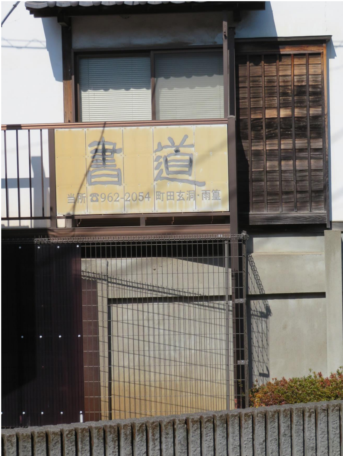
経年劣化した自作の看板。市内局番が現在と異なっている。
